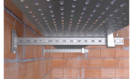
Staffaggio di impianti elettrici.
